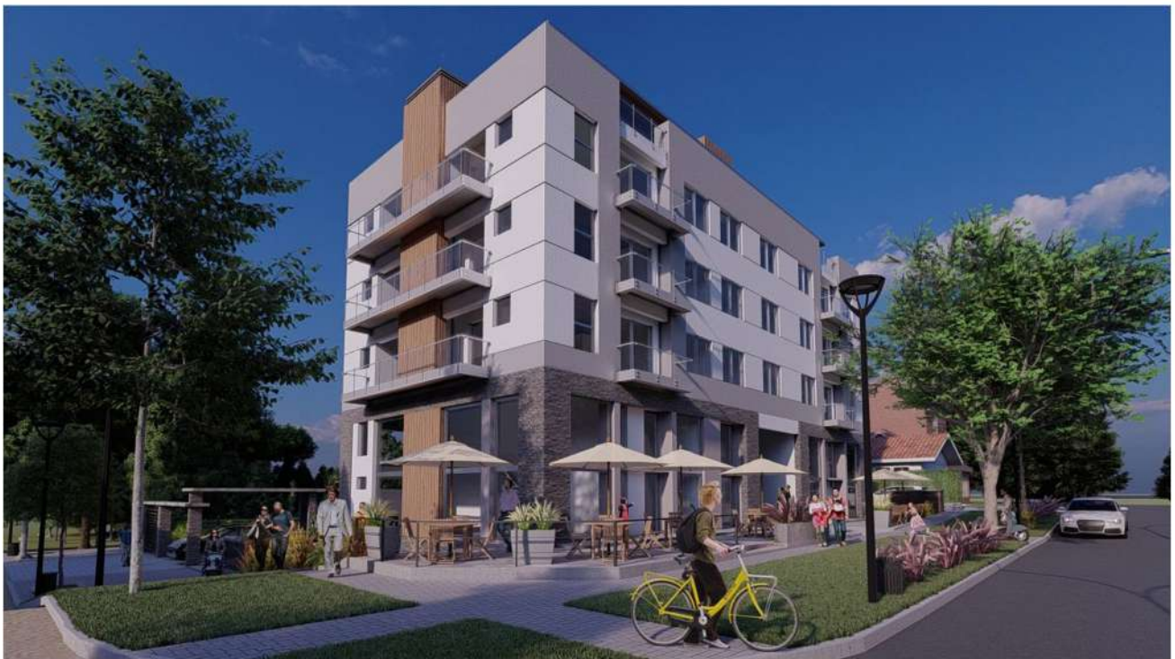
AVENIDA ESPORA Y CALLE LORIA VALERIA DEL MAR.
